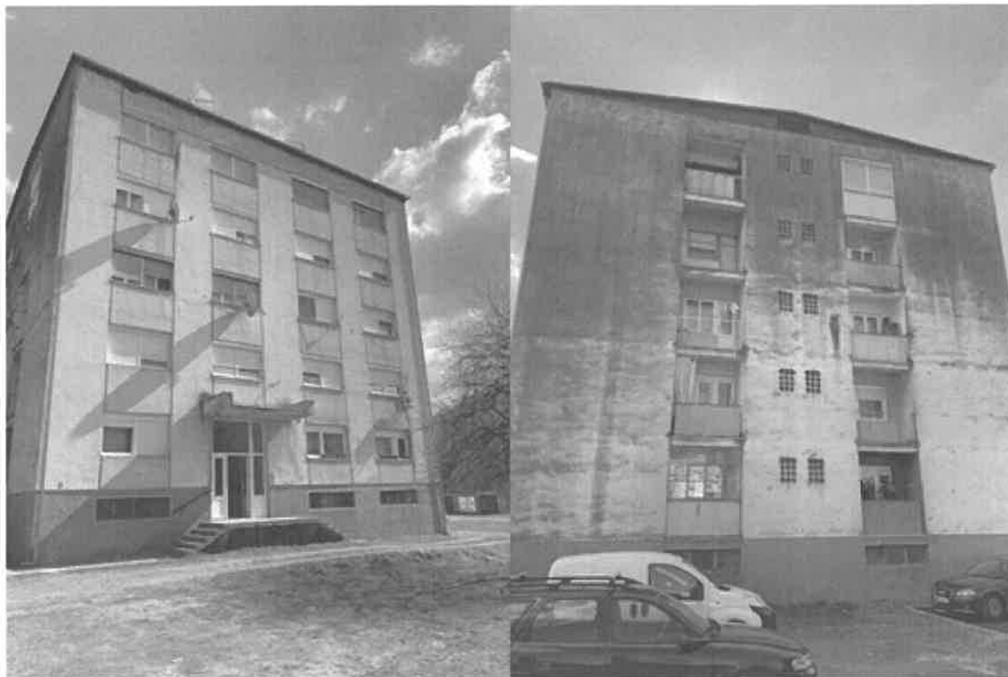
Prije energetske obnove
